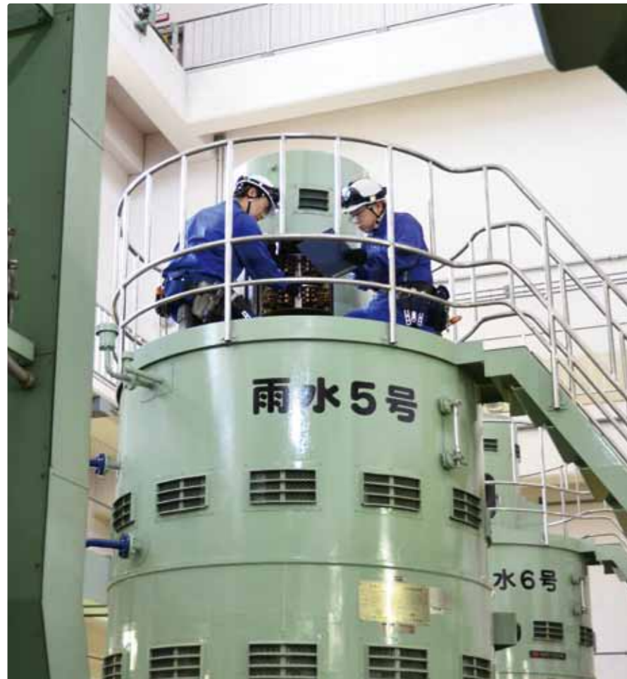
主ポンプ電動機点検
